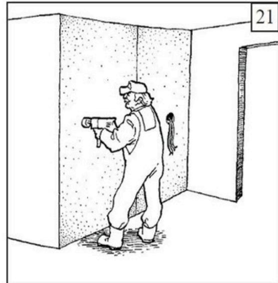
20. Os núcleos ocos são usados para passar os cabos e as caixas elétricas são perfuradas até qualquer ponto desejado.
